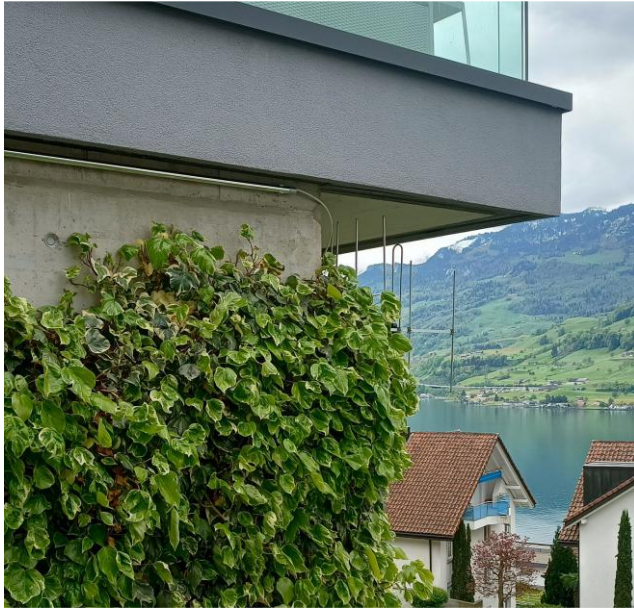
Aussen: Die kaum erkennbare Empfangsantenne für DAB.
