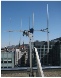
sur le toit
