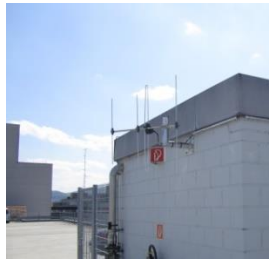
sur un mur
