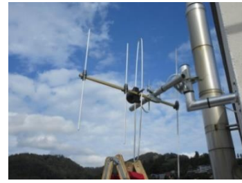
sur un mât existant
