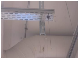
Beispiel: Magnetfussantenne an einem Elektrokanal
