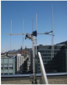
auf dem Dach
